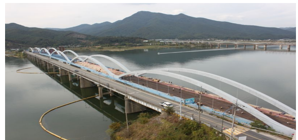
(구 양수대교 재가설 공사)
